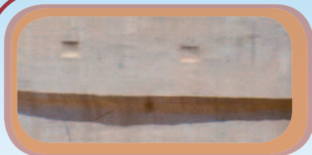
Abb. 7: Der obere Wandabschluß zeigt, wie akkurat die Wand bearbeitet wurde
