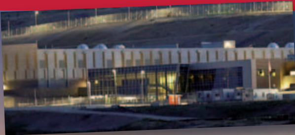
Das Utah Data Center ist Tag und Nacht streng bewacht
